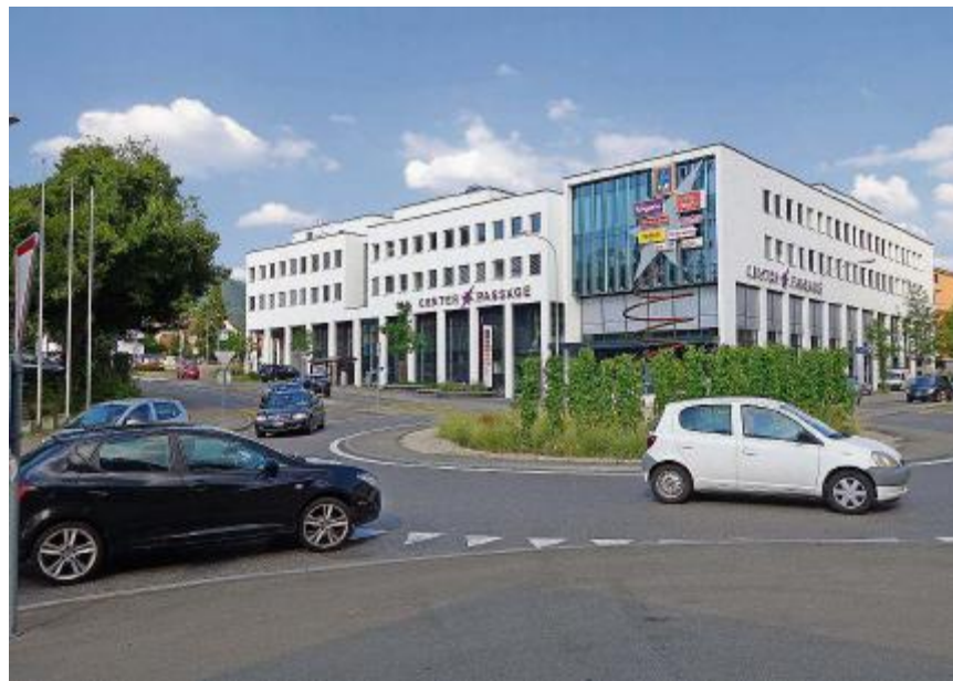
Baulich dominiert die Centerpassage die Landstrasse, kommerziell konnte sie sich bisher nicht richtig etablieren.
